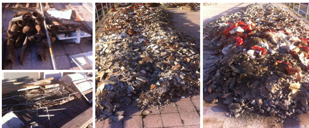
Слика 7. Привремена депонија грађевинског отпада
